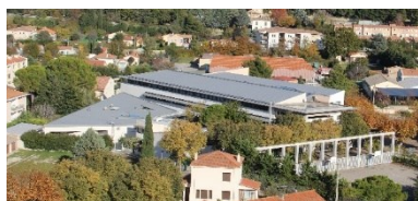
Lycée Professionnel Les Ferrages à Saint-Chamas
