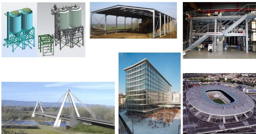
Figure 8: autres exemples d'ouvrages d'architecture en métal
