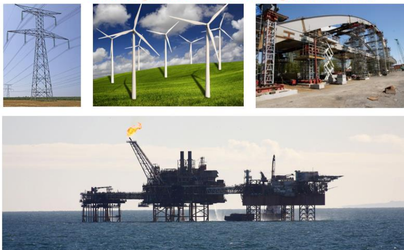
Figure 7: autres exemples d'ouvrages d'architecture en métal
