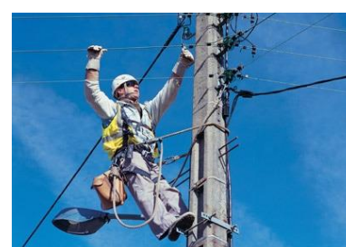
Monteur en réseau de distribution
