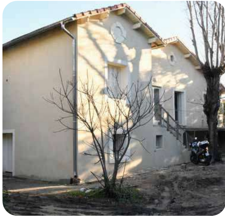
La Maison Flammarion, située boulevard Capdevilla, offre une surface habitable de 170 m 2
