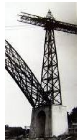
Pylône du Viaduc du Garabit en 1884
